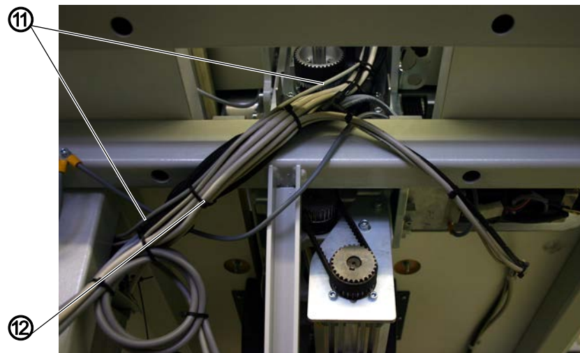
Abb. 11: Zuleitung B verlegen
