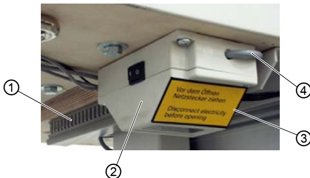
Obr. 42: Montáž a připojení transformátoru osvětlení šicího stroje (1)
